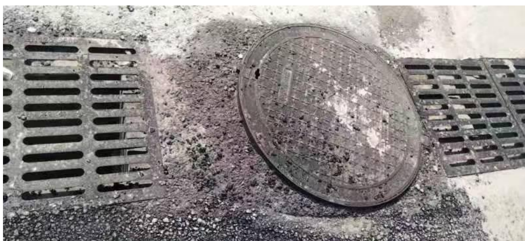
图 3-4 生活废水排放口
